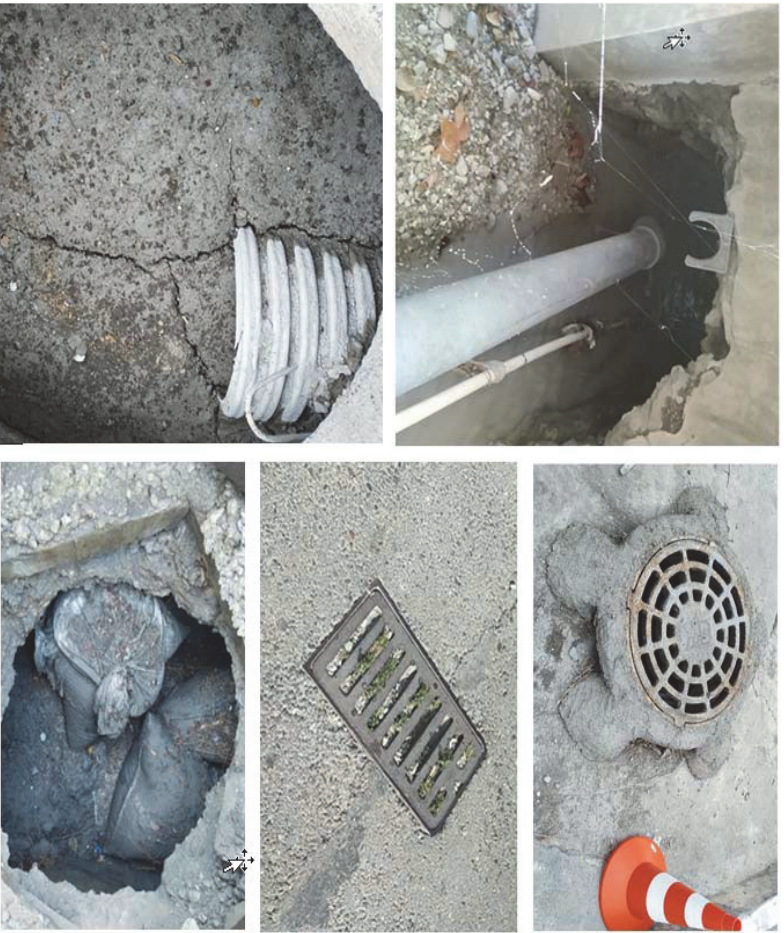
Рисунок 1.6 – Проблемные участки на сетях ливневой канализации
