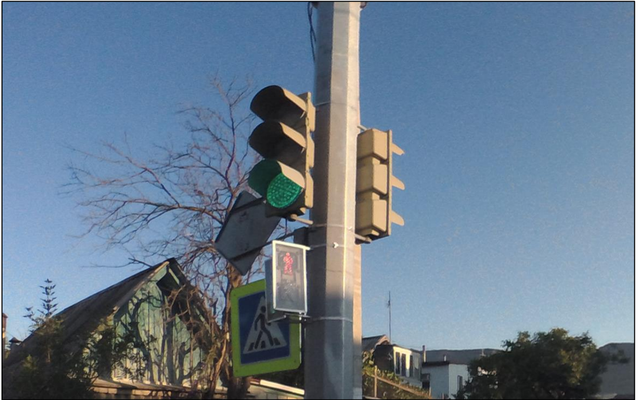
Рисунок 1.7.1 – Пример эксплуатационного состояния светофоров Т.1, П.1, расположенных в г. Геленджике на пересечении ул. Новороссийская – ул. Первомайская
