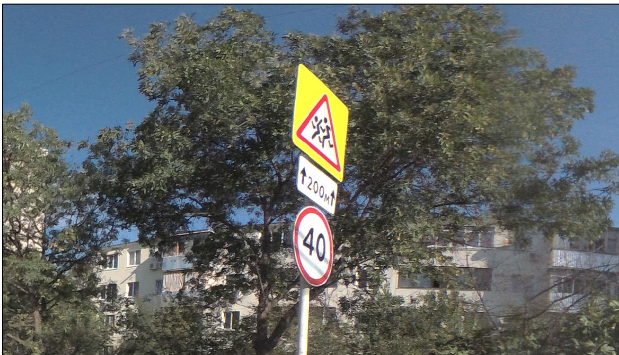
Рисунок 1.7.3 – Вид эксплуатационного состояния знаков 1.23 «Дети» на желтом фоне и знака 3.24 «Ограничение максимальной скорости» расположенных по ул. Сурикова, г. Геленджик
