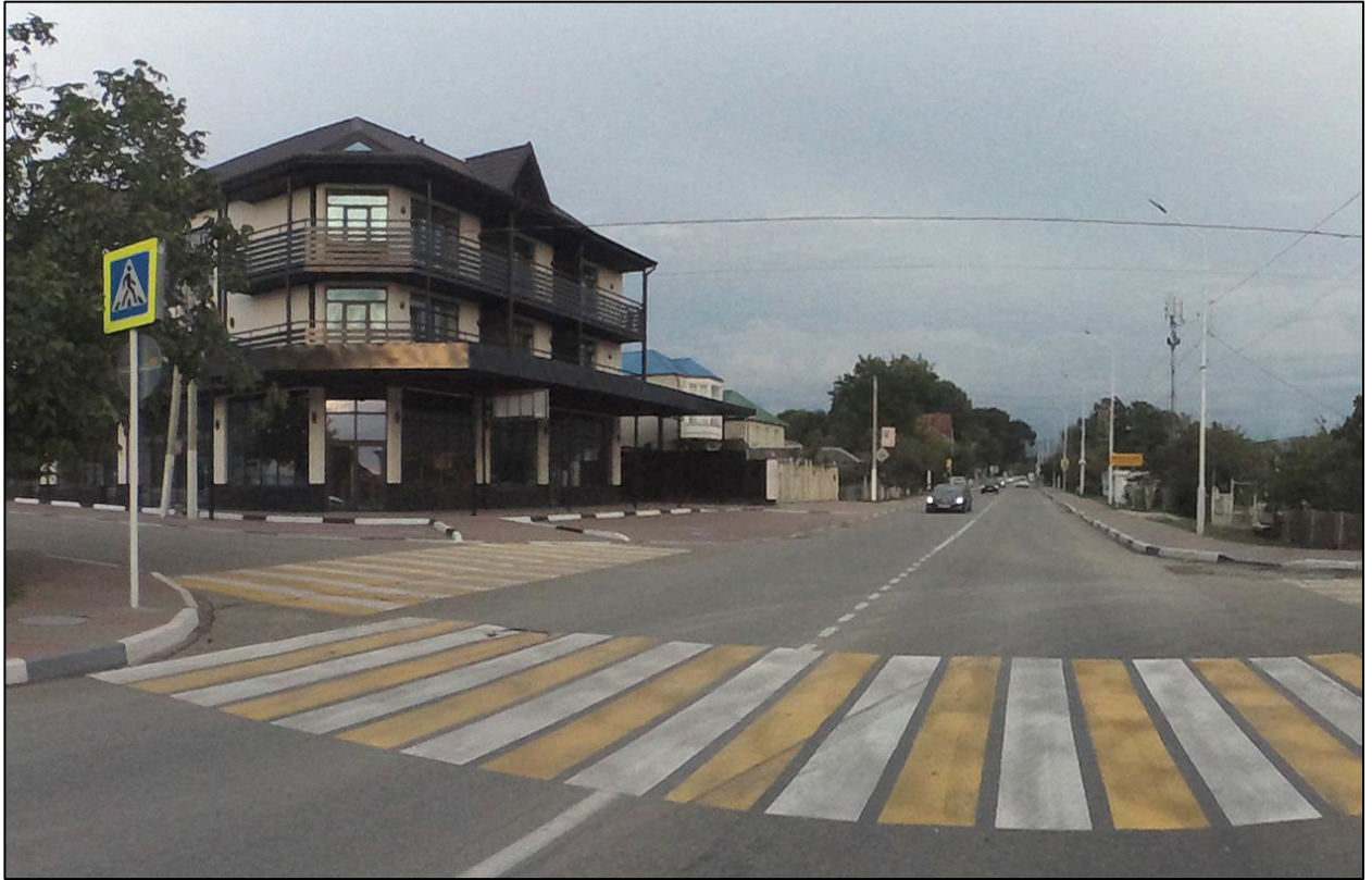
Рисунок 1.7.6 – Пример эксплуатационного состояния горизонтальной разметки 1.1 и разметки 1.14.1 с желтым заполнением (обозначающей пешеходный переход), нанесённых в с. Кабардинка по ул. Революционной
