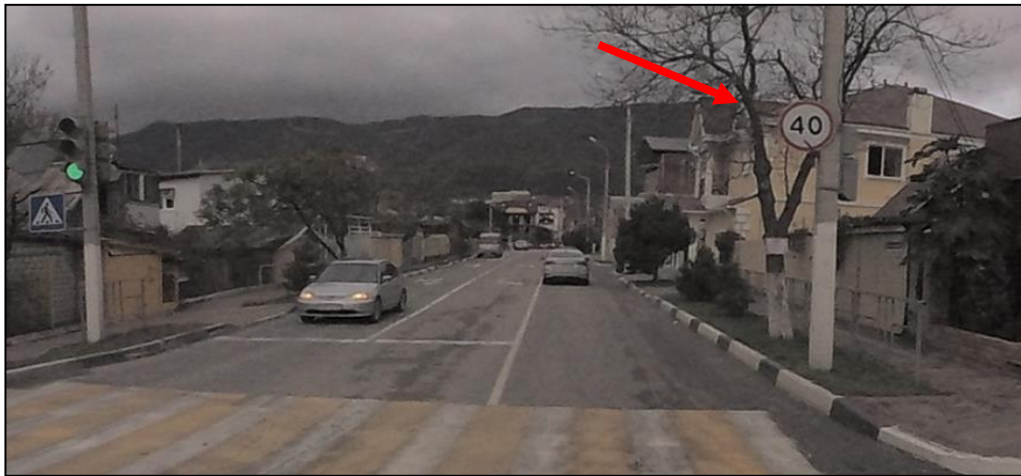
Рисунок 1.9.2 – Участок дороги ул. Новороссийской (от ул. Первомайской до ул. Островского) на момент обследования
