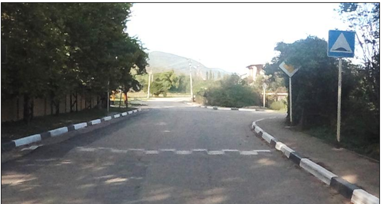
Рисунок 1.7.10 – Пример эксплуатационного состояния ИДН монолитной конструкции, расположенной в с. Пшада, ул. Красная
