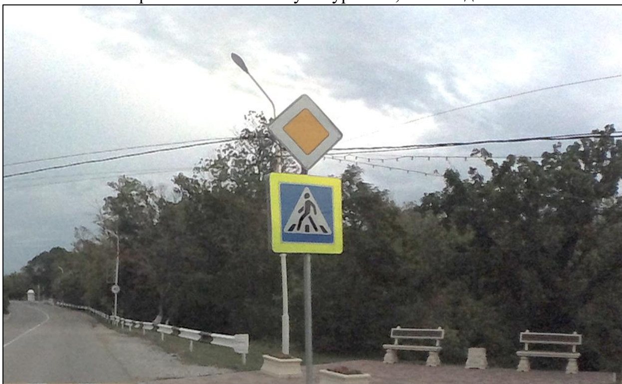
Рисунок 1.7.4 – Вид эксплуатационного состояния знаков 5.19.1 «Пешеходный переход» на желтом фоне, 2.1 «Главная дорога» расположенных по ул. Революционная, с. Кабардинка
