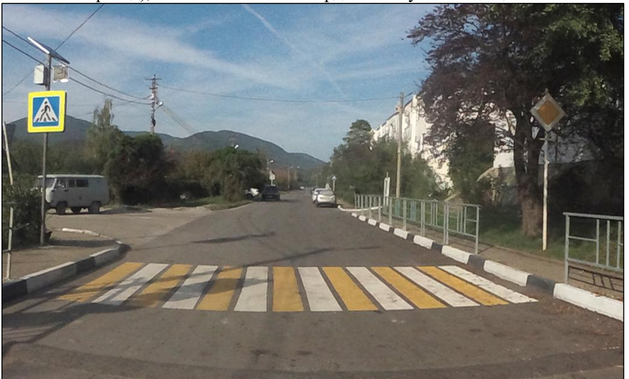
Рисунок 1.7.7 – Пример эксплуатационного состояния горизонтальной разметки 1.14.1 с желтым заполнением (обозначающей пешеходный переход) и вертикальной разметки 2.7, нанесённых в с. Пшада по ул. Школьной
